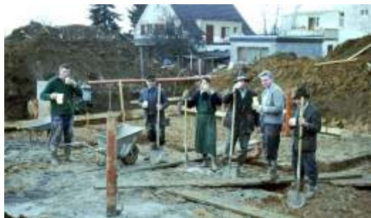
Jede Menge helfende Hände auch beim Bau des Pastorenhauses.
